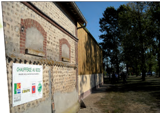
La chaufferie centrale (photo Biomasse Normandie)
