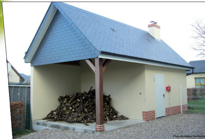
La chaufferie bois/fioul
