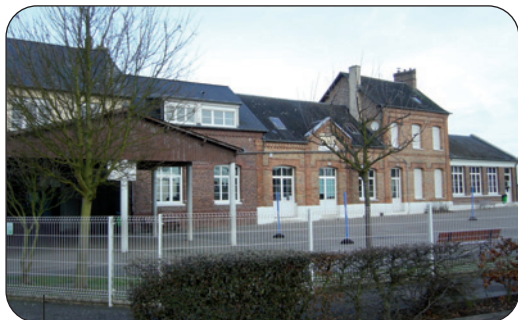
Le groupe scolaire de Vatteville-la-Rue
