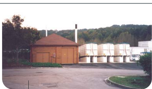
La chaufferie bois/propane et conteneurs
