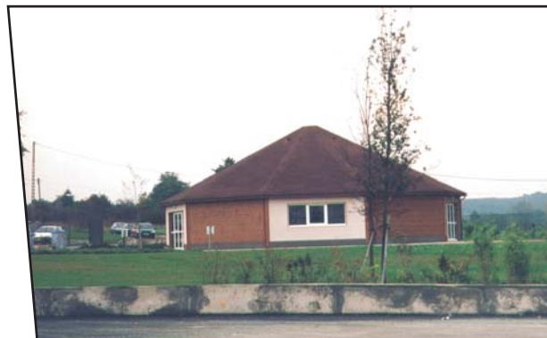
La salle polyvalente chauffée au bois
