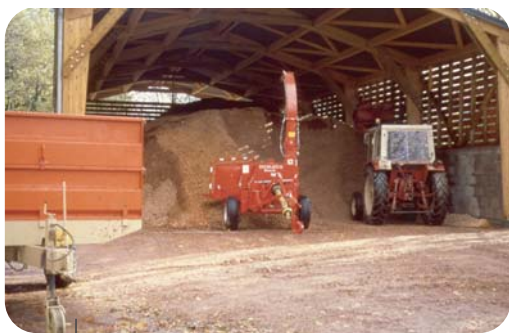
Le hangar de stockage - séchage du combustible bois
