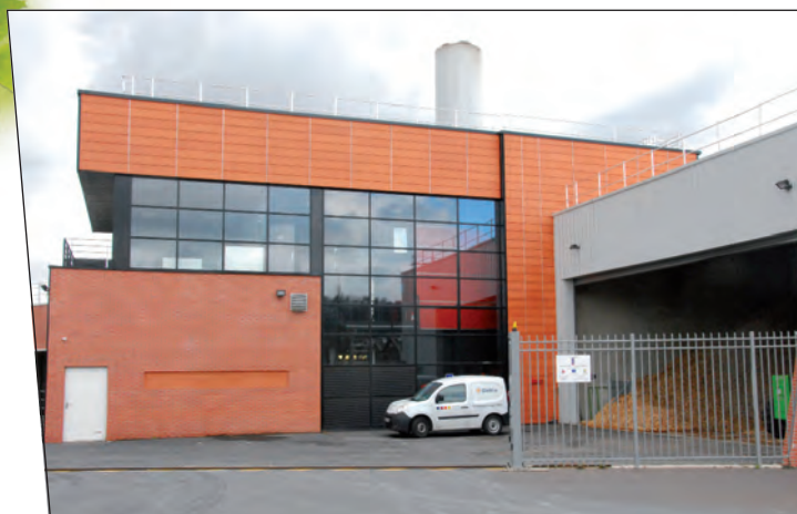
La chaufferie centrale (photo CEDEN)
