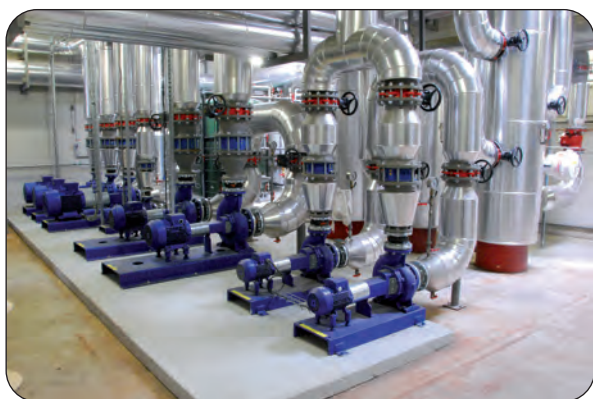
La chaudière bois et les départs du réseau (photos Biomasse Normandie / CEDEN)
