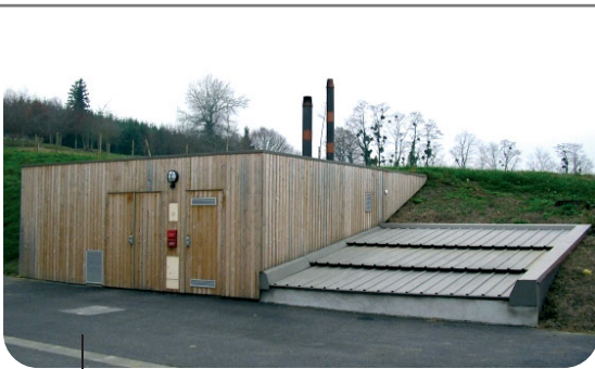
La chaufferie et son silo de stockage enterré
