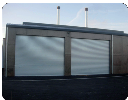
Le silo de stockage
