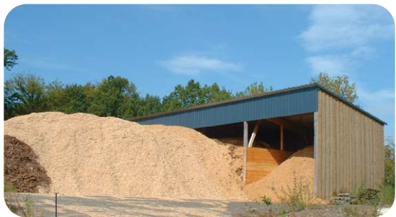
La plate-forme de stockage du combustible
