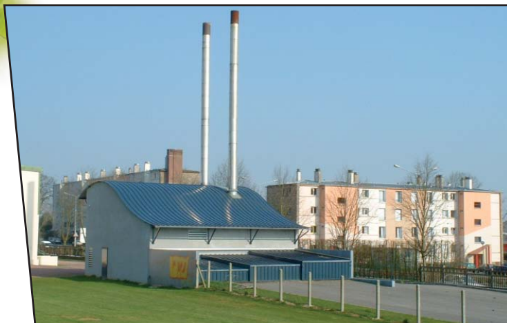
La chaufferie bois et les logements HLM raccordés au réseau
