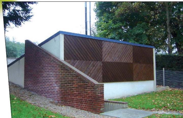
La chaufferie bois
