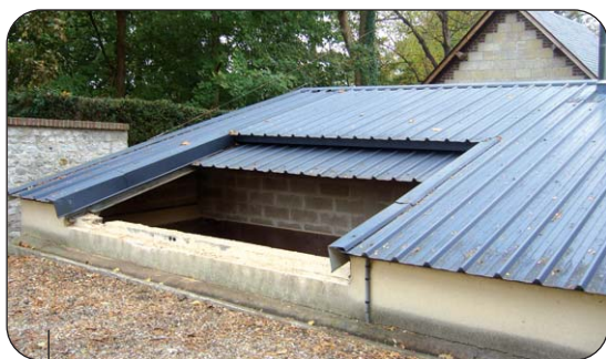
Le silo enterré contigu à la chaufferie
