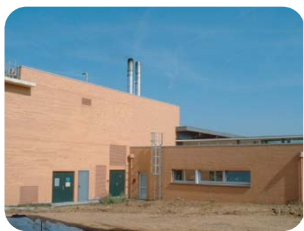
La chaufferie bois / fioul
