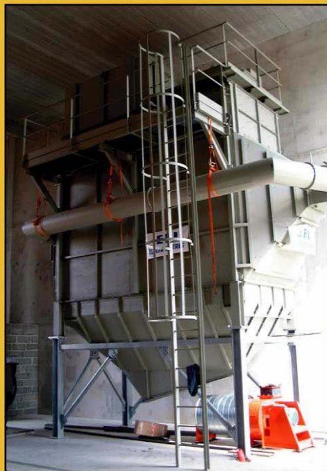
L'électrofiltre en cours de montage
