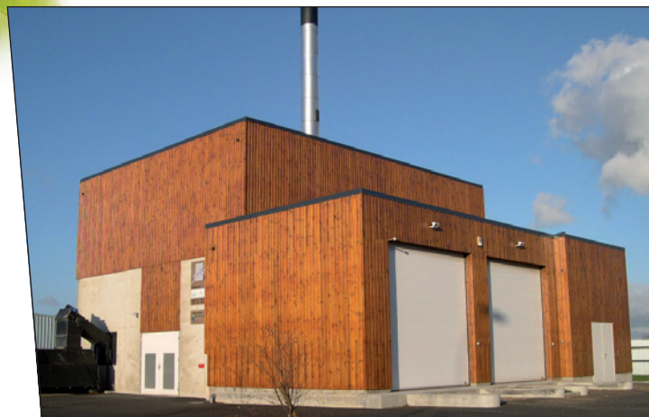
La chaufferie et son silo de stockage - Photo SAGIM
