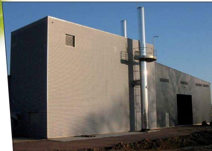
La chaufferie centrale (photo GRAM)
