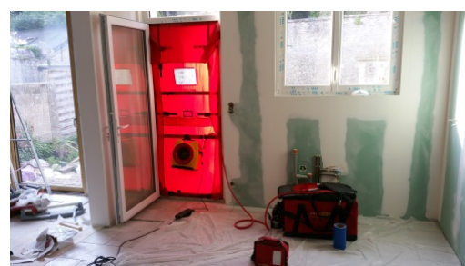
Test d'étanchéité - Mai 2015
