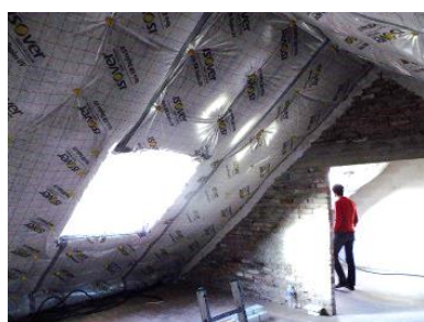
Isolation par l'intérieur des combles - Mai 2015
