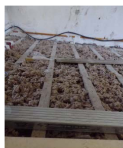
Isolation du plancher bas - Mai 2015
