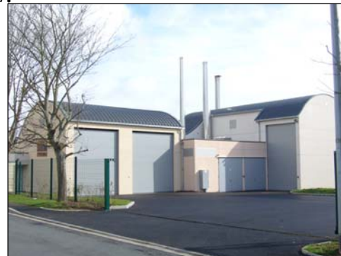
Chaufferie de Bayeux Vallée des Prés
