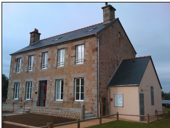
Mairie/Logements à Ronfeugerai (55 kW- granulés)
