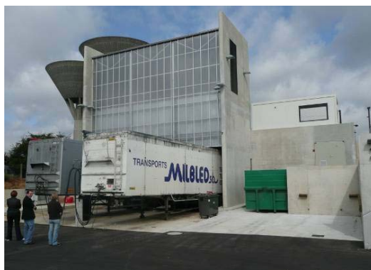
Le quai de transfert d'Argentan
