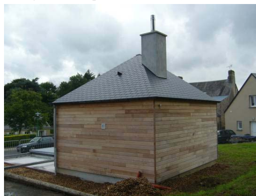
Chaufferie de La Lucerne d'Outremer (100 kW)
