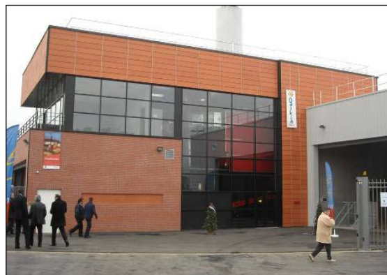
Chaufferie du Quartier Grammont à Rouen (4 800 kW)
