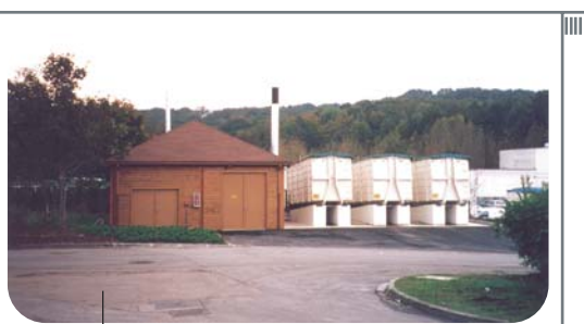
La chaufferie bois/propane et conteneurs
