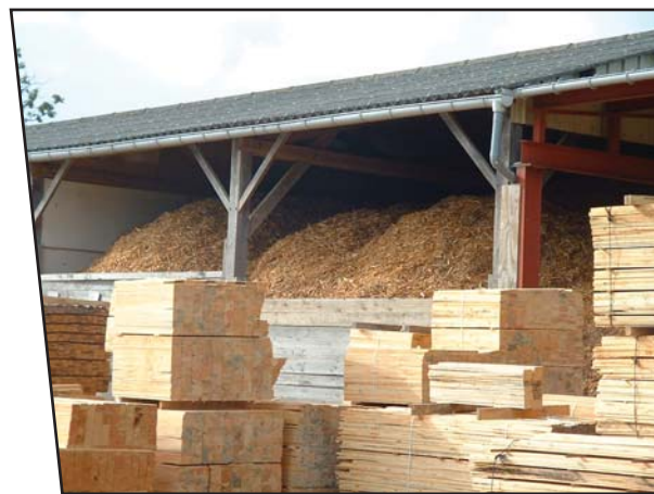
Le stockage des matières premières et du combustible bois
