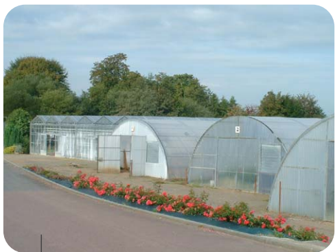
Les serres chauffées au bois
