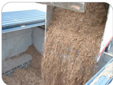
La livraison du combustible
