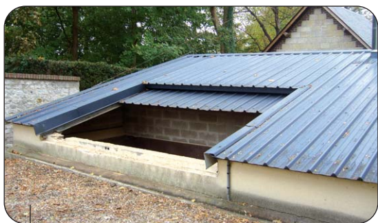
Le silo enterré contigu à la chaufferie
