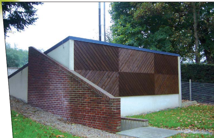
La chaufferie bois
