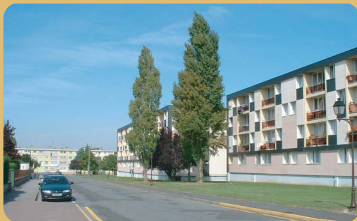
Une partie des logements chauffés au bois
