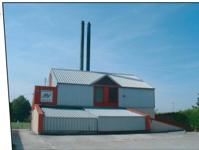
La chaufferie bois/fioul
