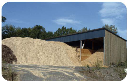
La plate-forme de la Ferté-Macé
