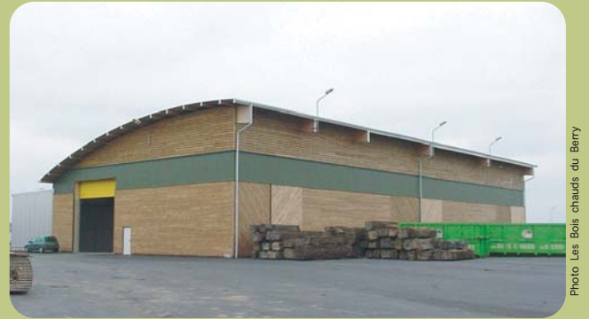
Le hangar de séchage (5 séchoirs)
