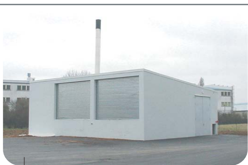
La chaufferie bois
