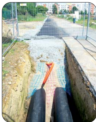
Le réseau enterré (phase chantier, rue Jean Moulin)
