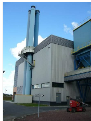
Unité de Valorisation Energétique du SIRAC à Colombelles (14 - Photo Biomasse Normandie)
